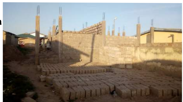
Alles is gereed om het stagiairverblijf af te bouwen
